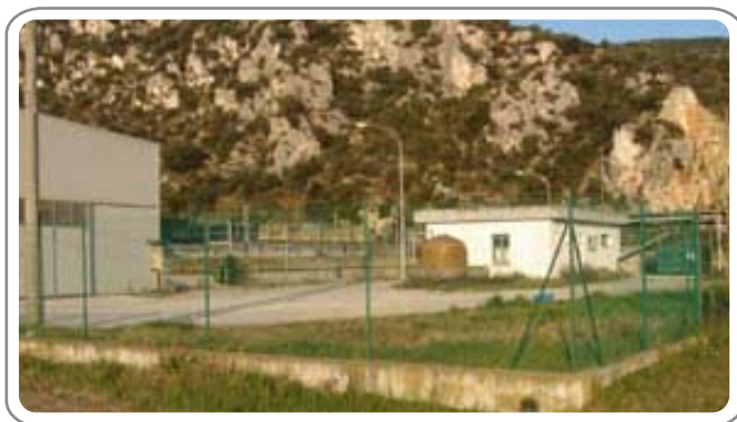
Depuratore di Vecchiano - Foto M. Angori
