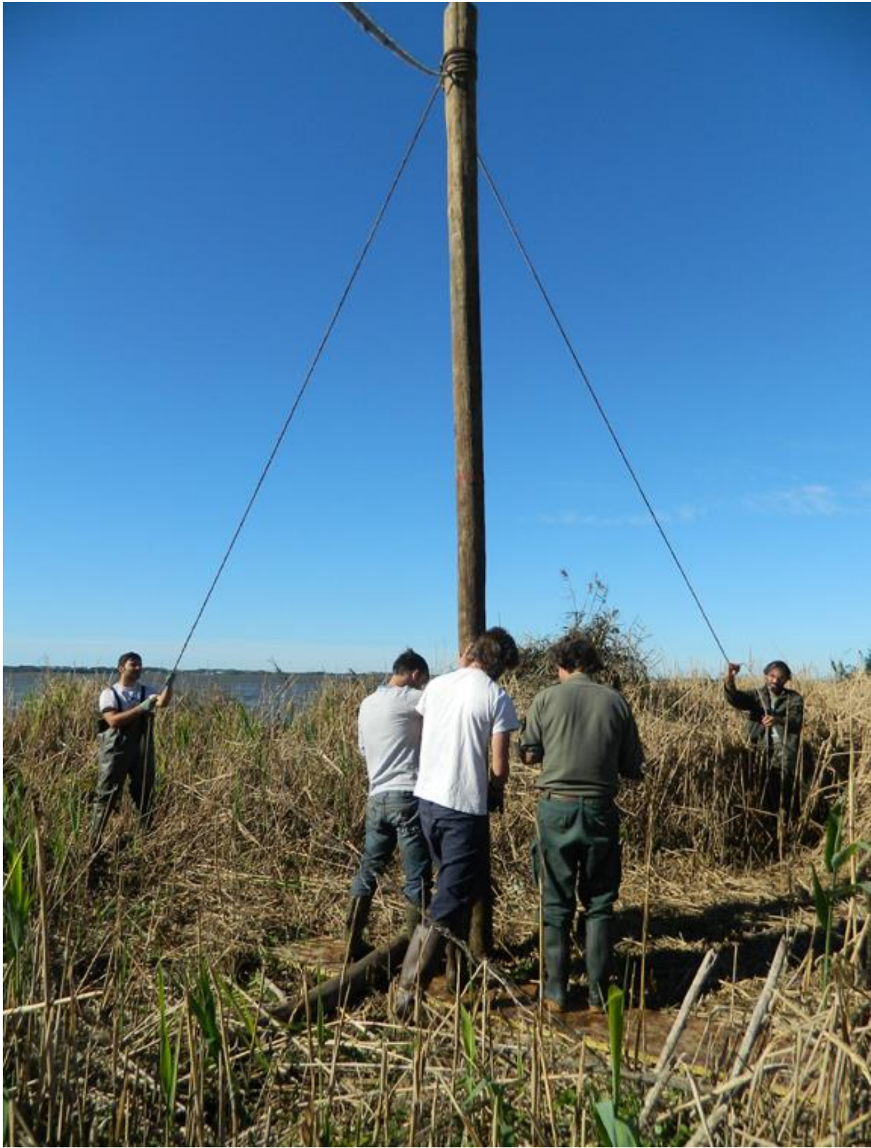
Figura 4: Fissaggio dell'isola palustre di 10.000 mq mediante l'infissione manuale di pali in legno.
